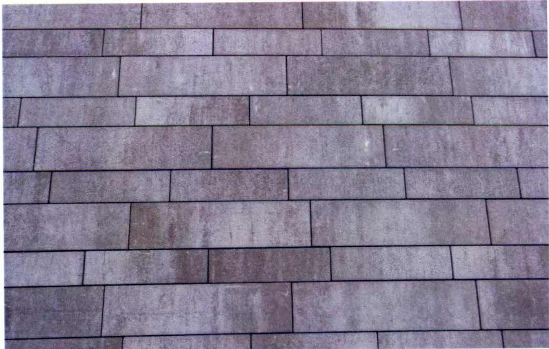
Bild: Brickado Graphit, Verlegebild
